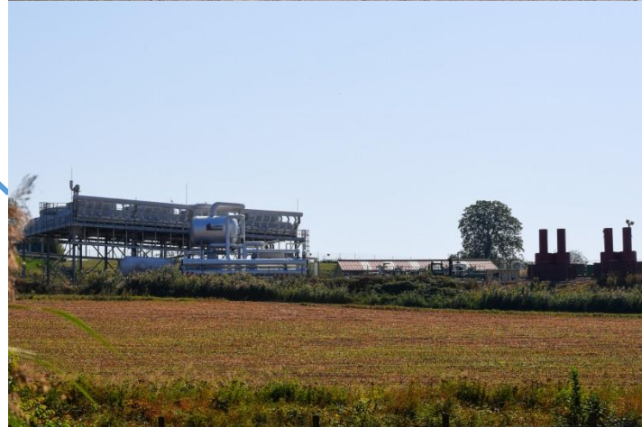
SOULTZ-SOUS-FORÊTS POWER PLANT
